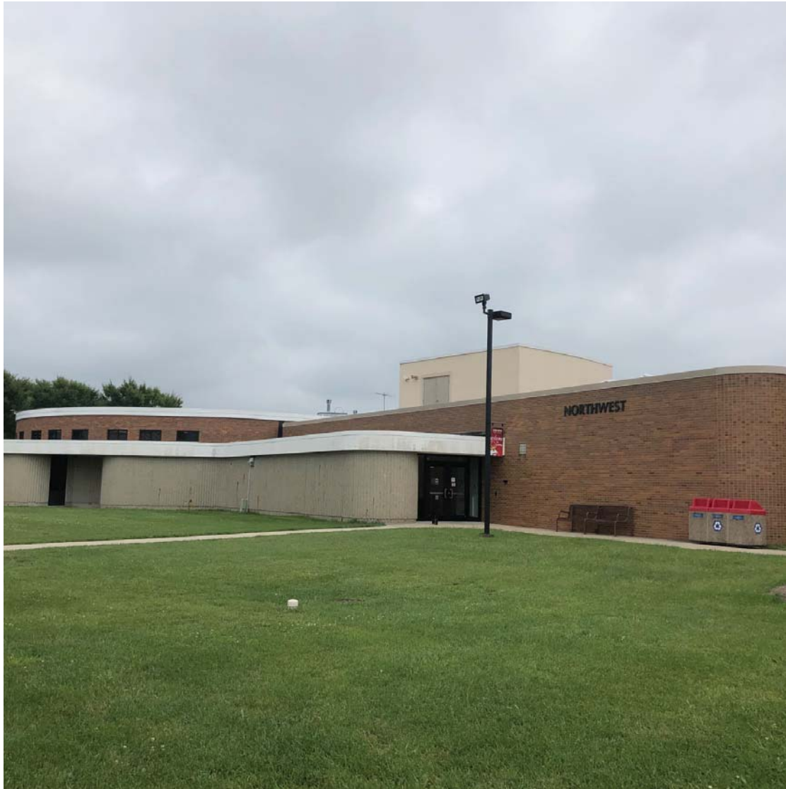
BLDG NO. LL03
