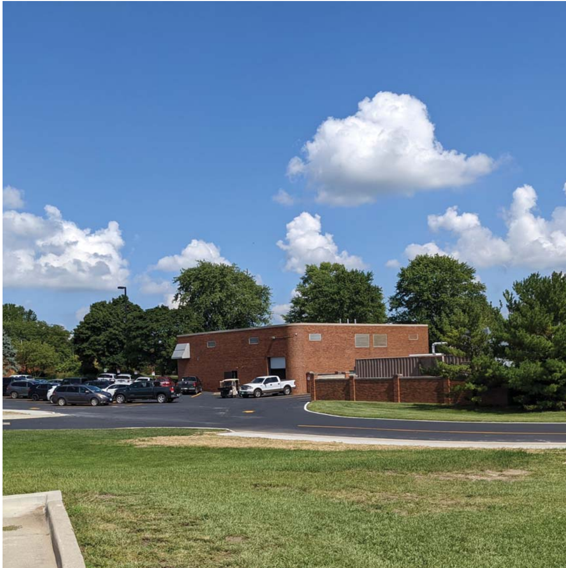
BLDG NO. LL85
