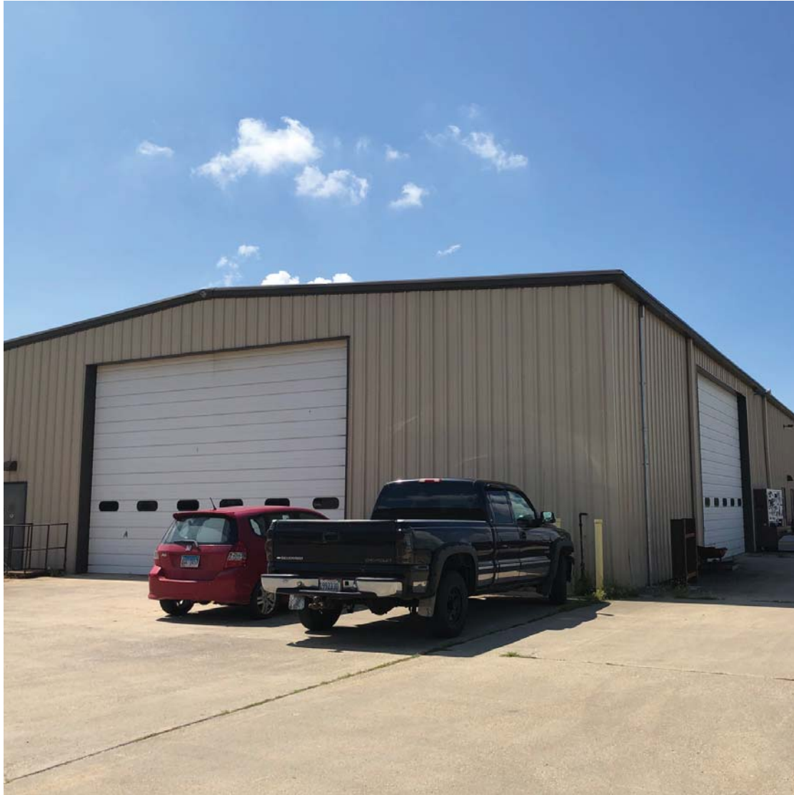
BLDG NO. LL84
