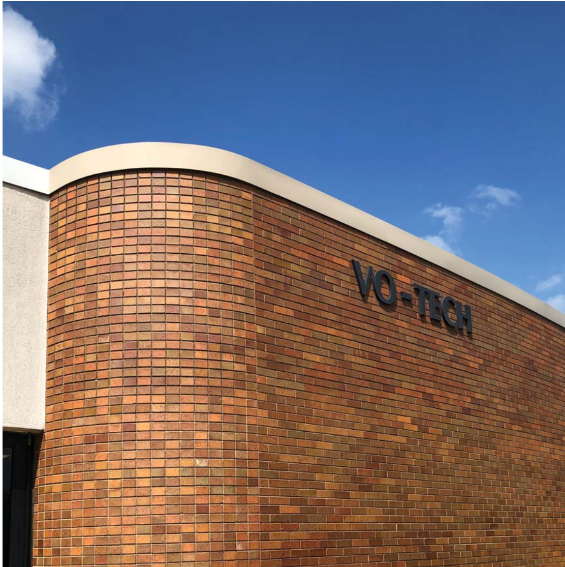
BLDG NO. LL08
