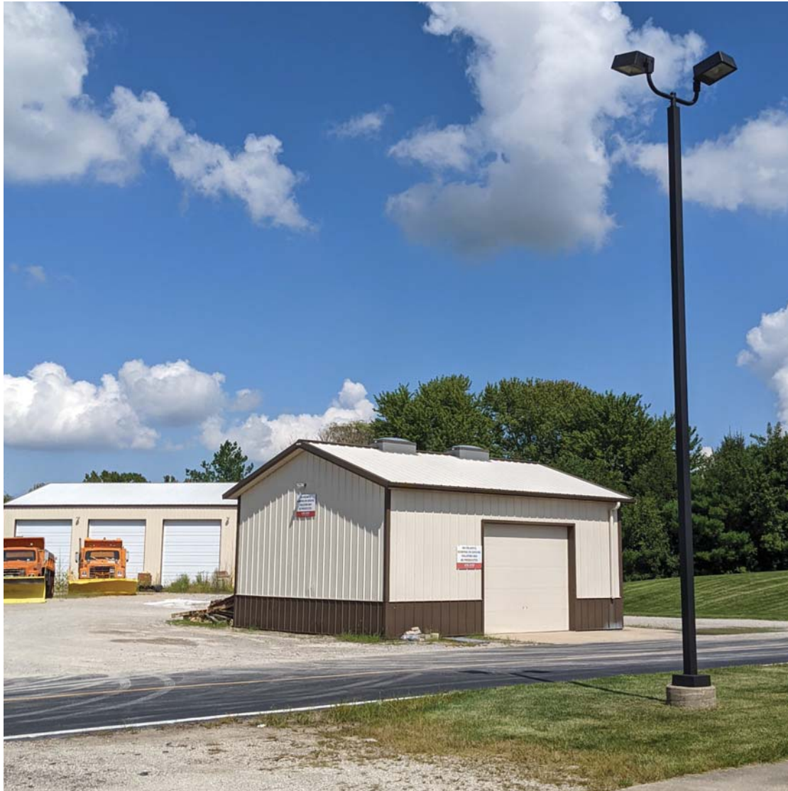
BLDG NO. LL82
