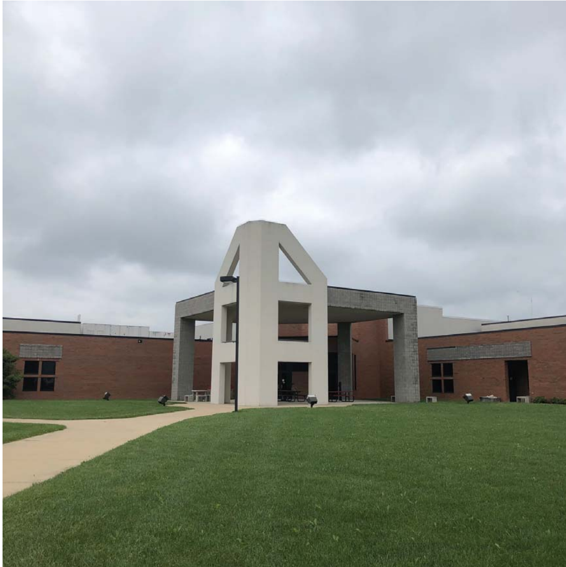
BLDG NO. LL10
