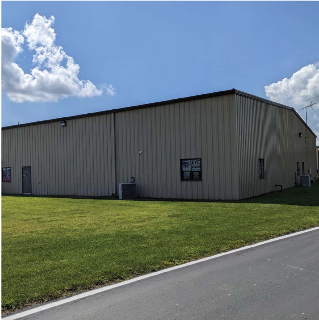
BLDG NO. LL83
