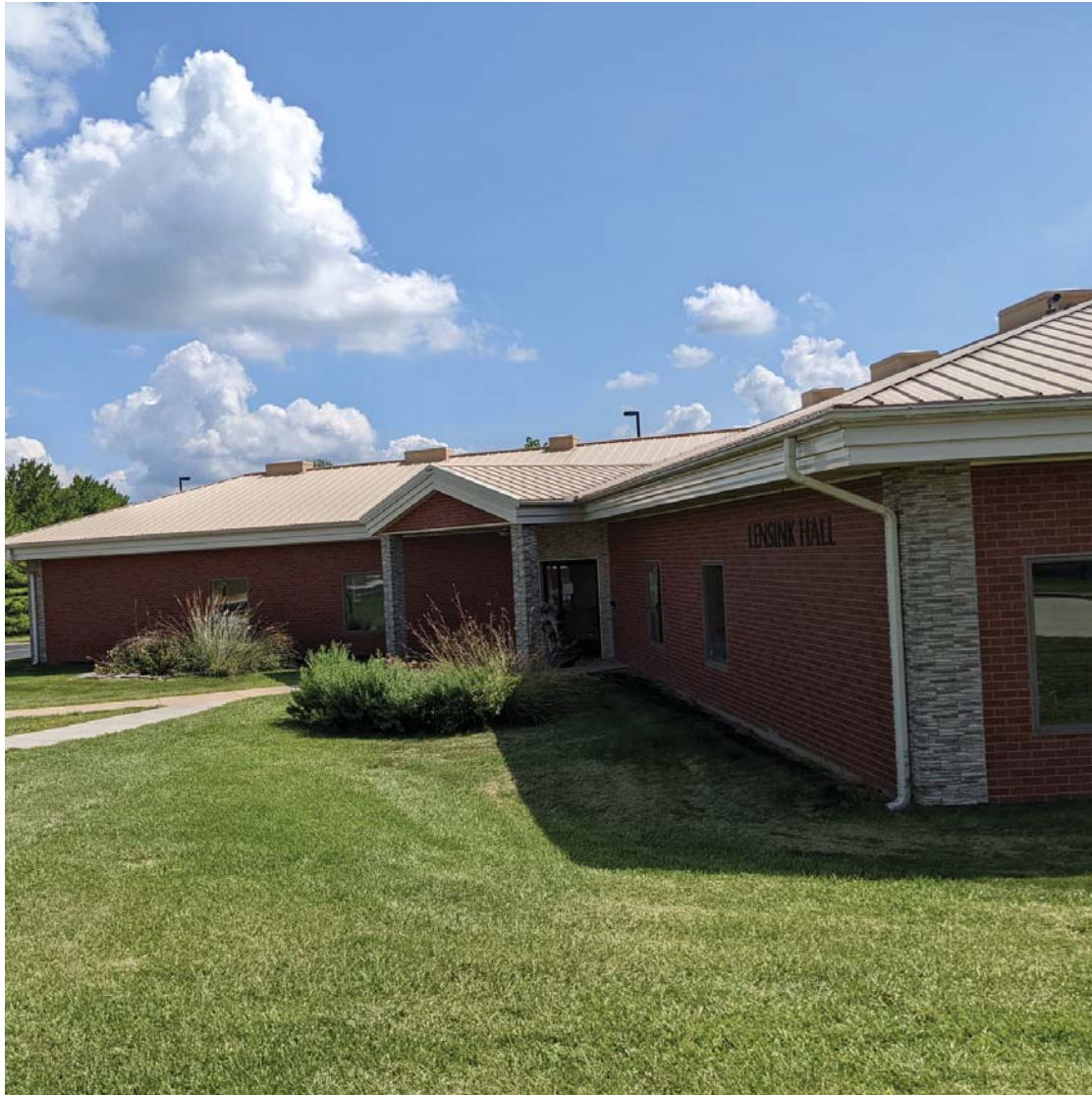
BLDG NO. LL12
