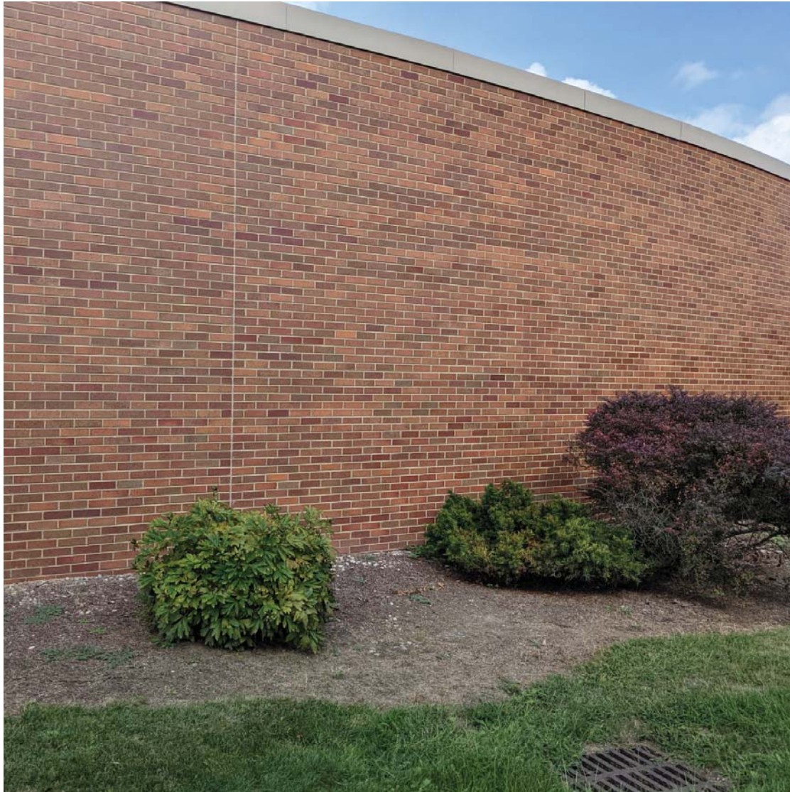
BLDG NO. LL05
