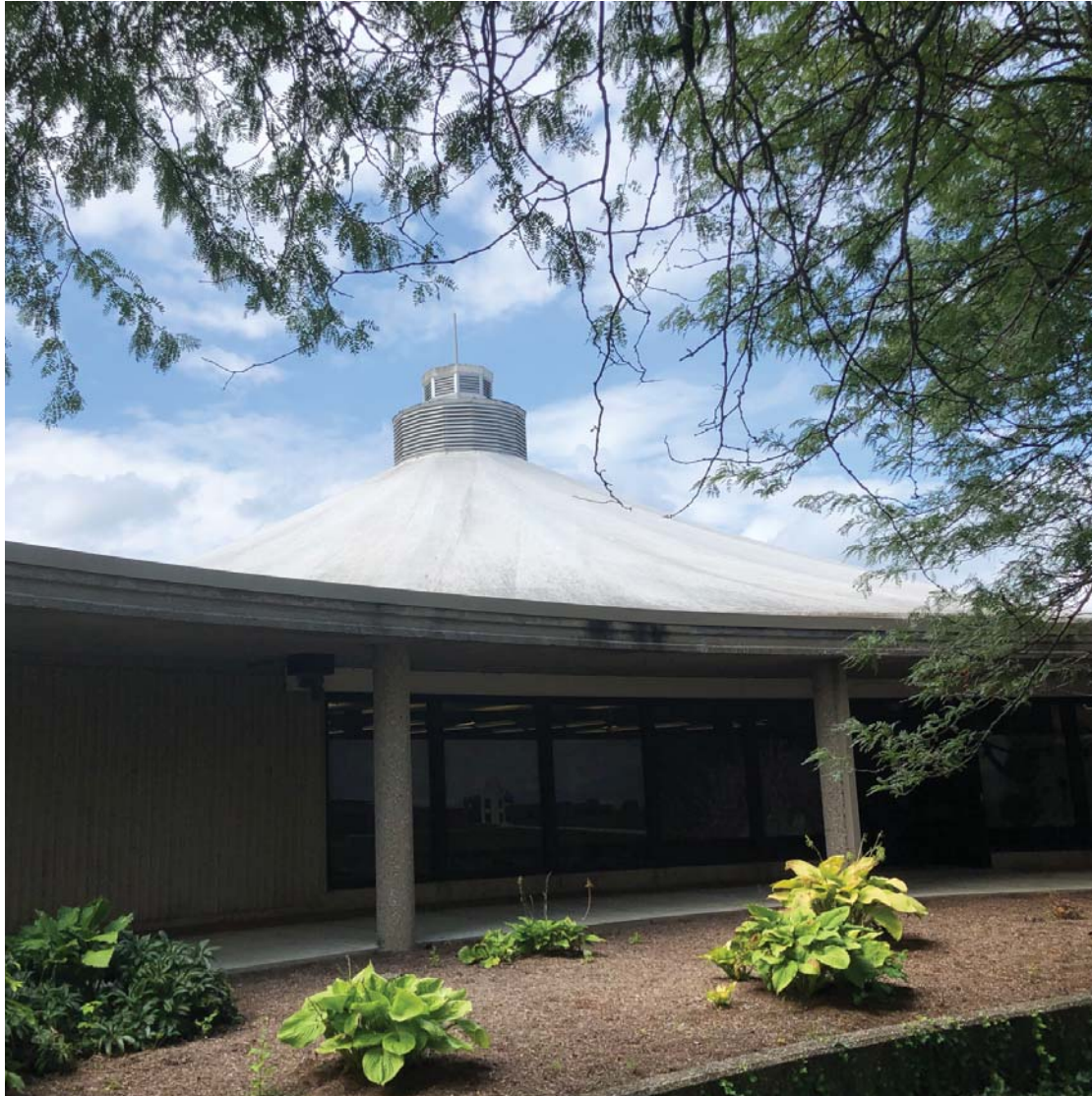
BLDG NO. LL01
