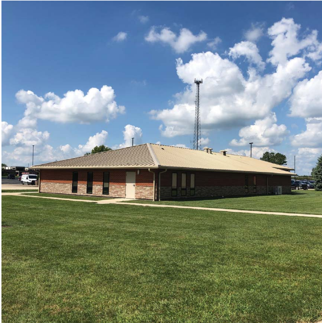
BLDG NO. LL11
