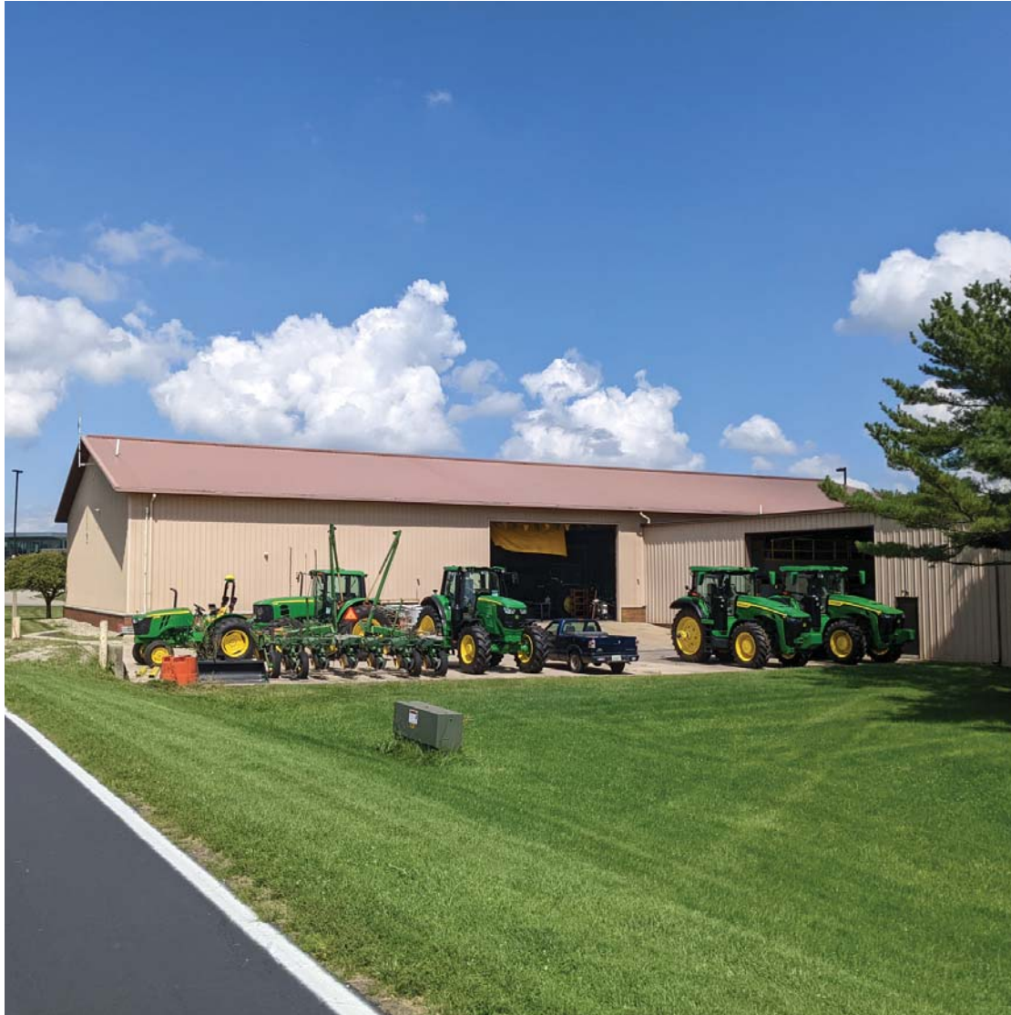
BLDG NO. LL09
