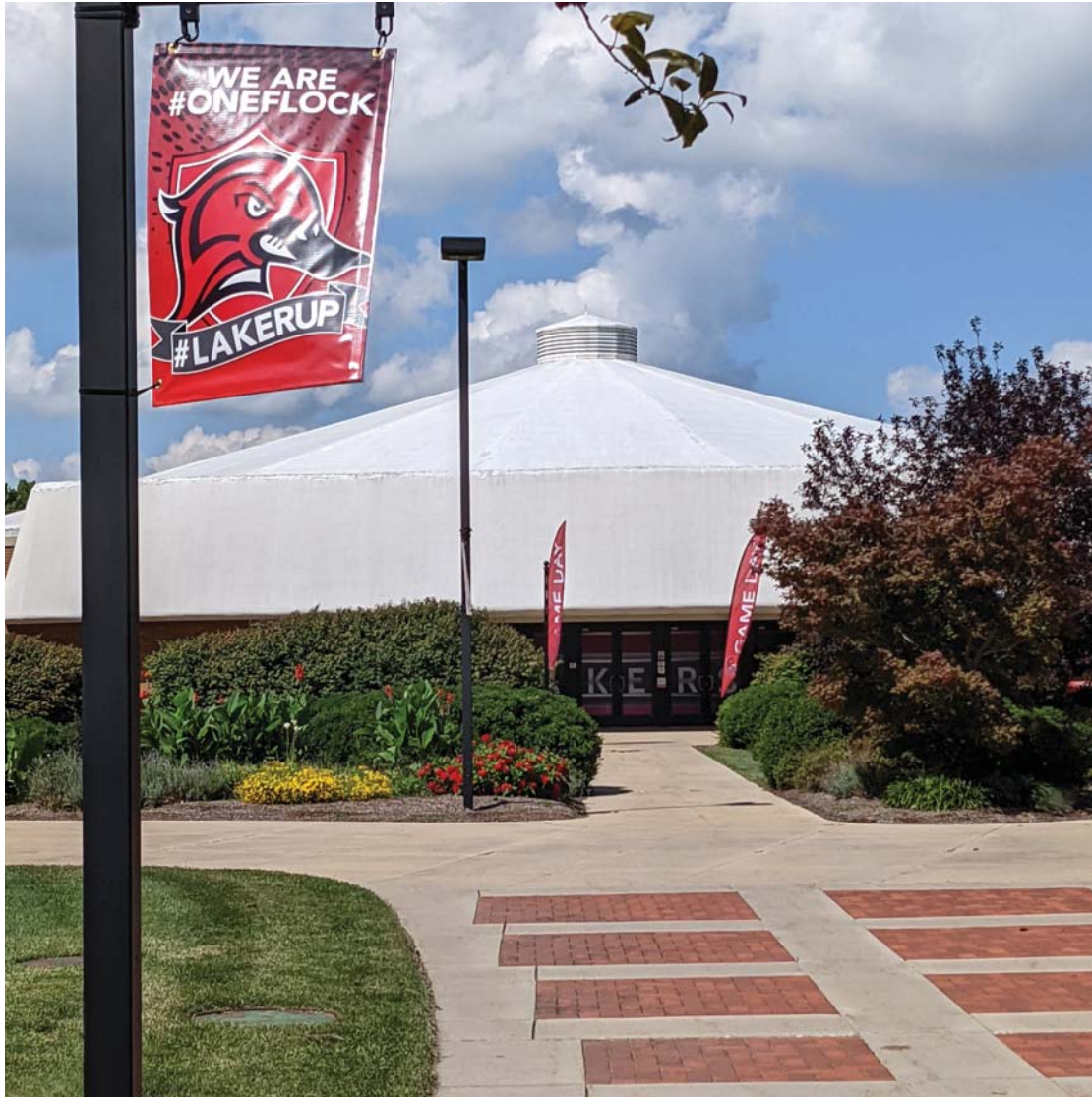
BLDG NO. LL04
