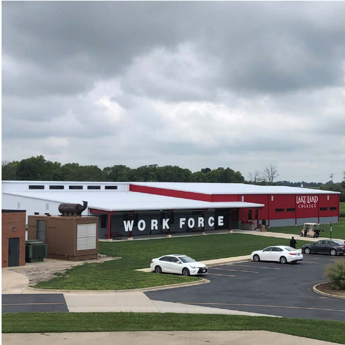
BLDG NO. LL14
