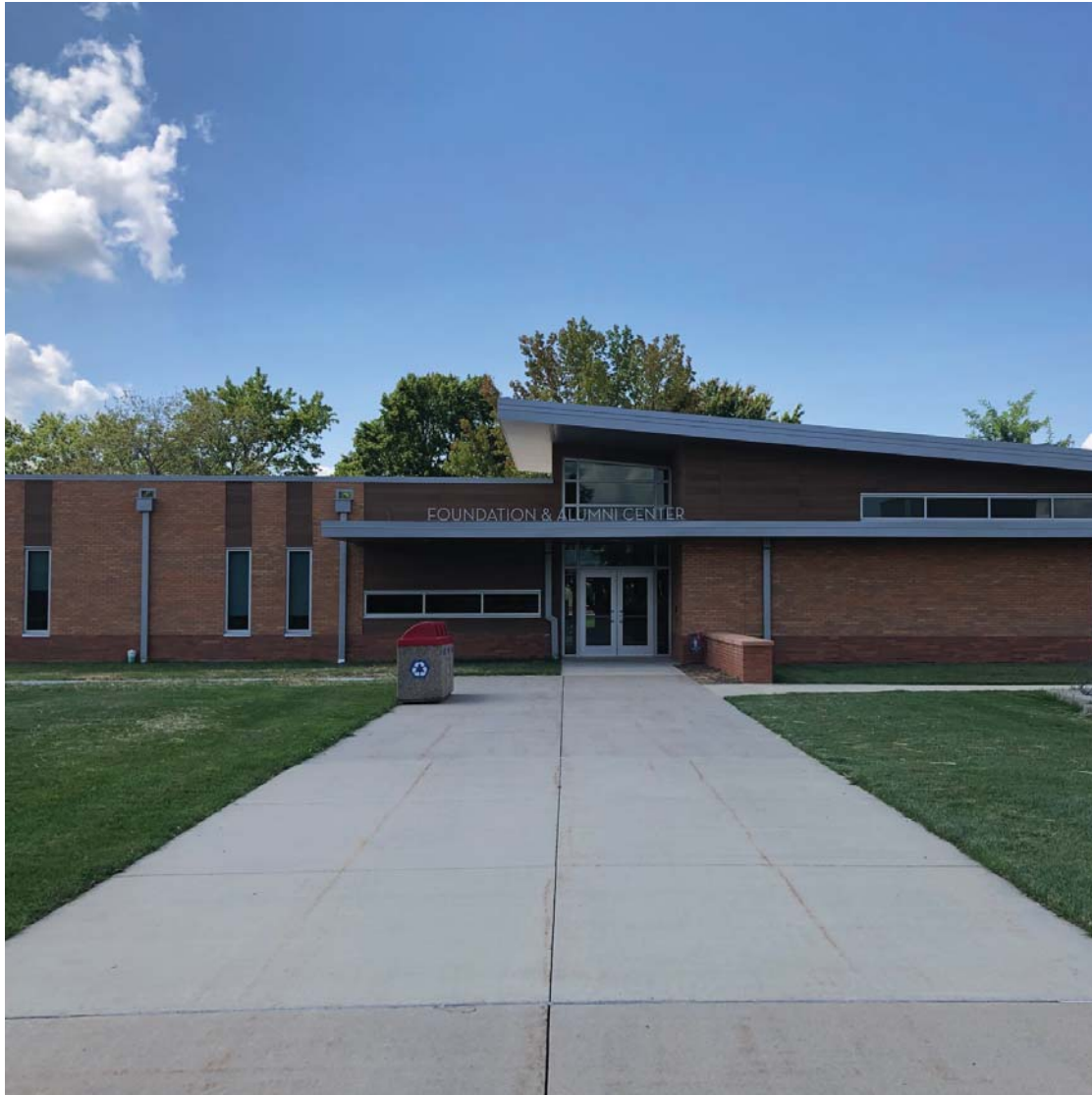
BLDG NO. LL13
