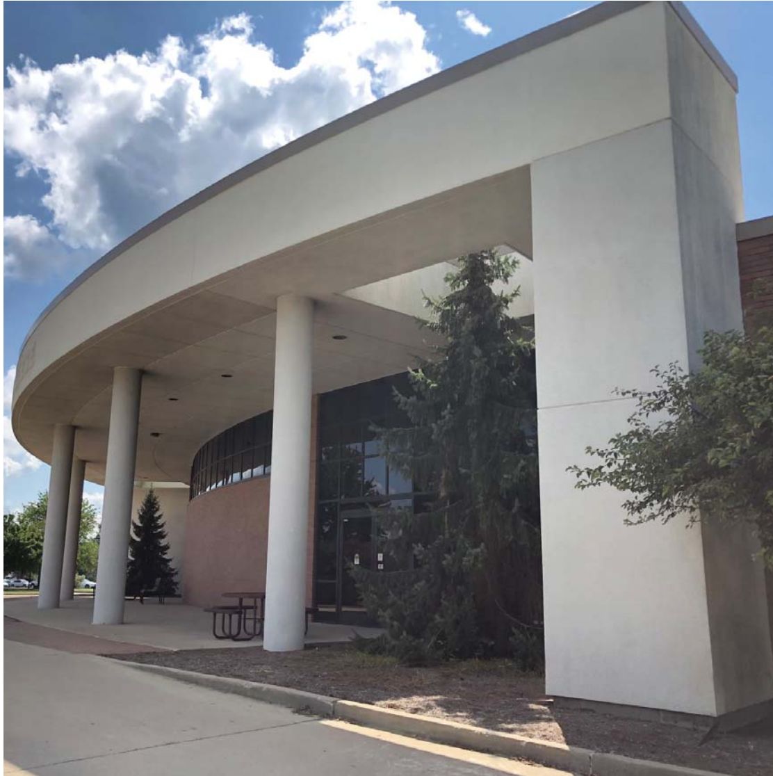
BLDG NO. LL06
